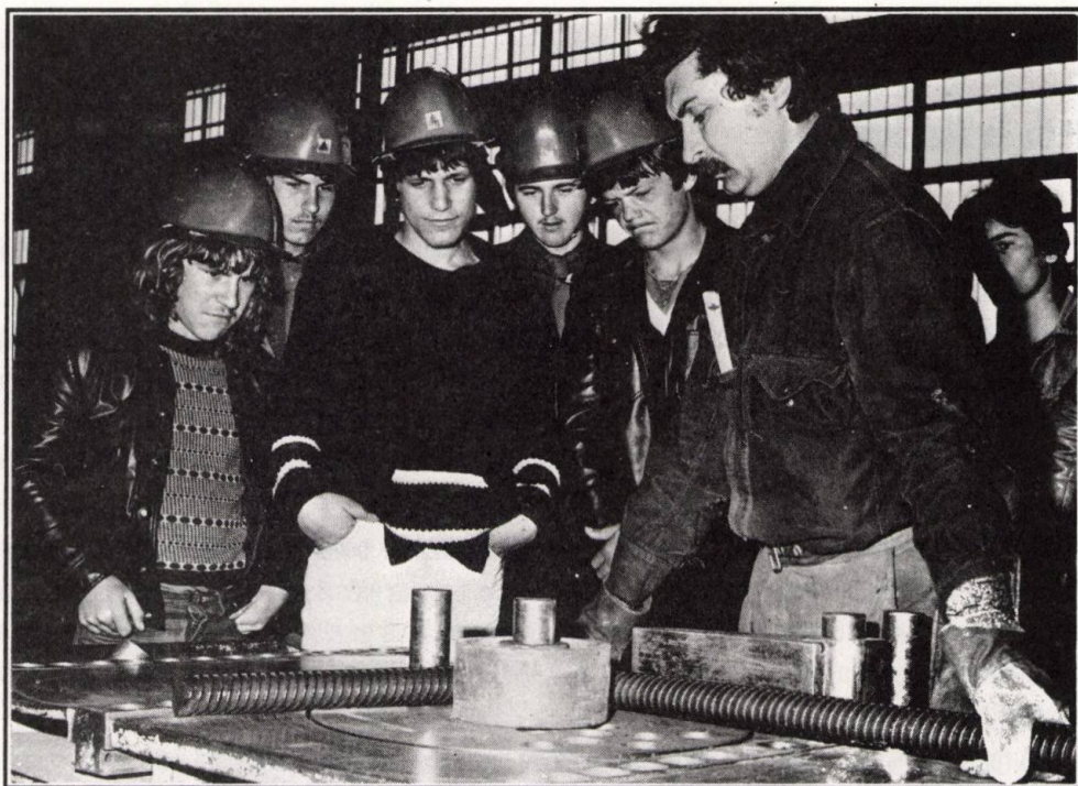
Brigádtalálkozó 1980. 05. 13. 40-es betonacél hajlítása
